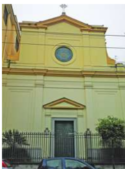
Chiesa S. Geltrude Torre del Greco
